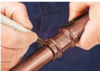
4. Zusammenbauen und die Einstecktiefe markieren
