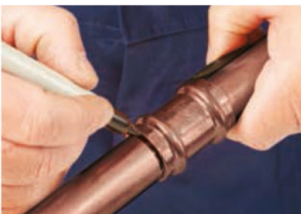
4. Zusammenbauen und die Einstecktiefe markieren
