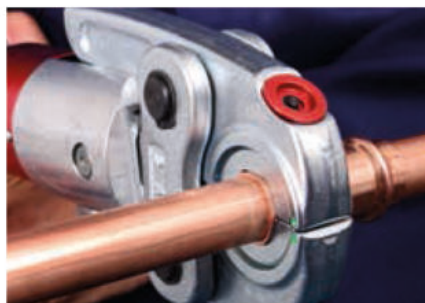
5. Fertigstellung der Verbindung mithilfe des Presswerkzeugs
